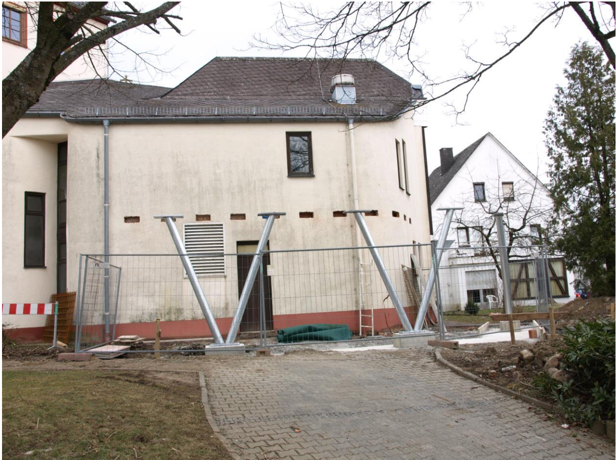
Auf Stelzen wird der Küchenanbau erstellt.
