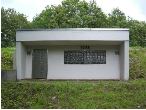
Bestand: Hochbehälter Mengerskirchen „Neu“ Bj. 1975
